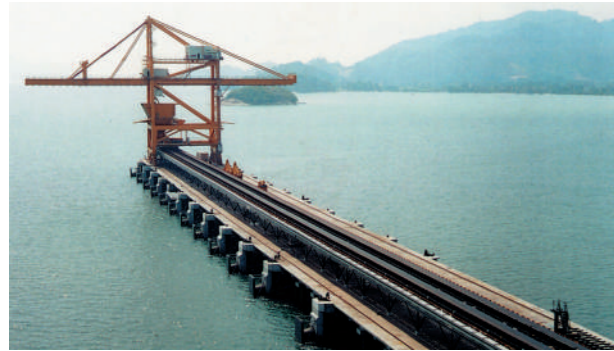
쉽 언로더 크레인에 적용된 장거리(441m) e체인 5050시리즈와 chainflex® CF CRANE
